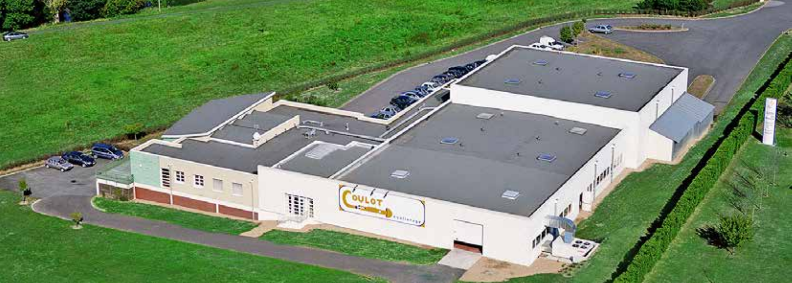
Aerial view of the Coulot Découletage site (Châtellerault - France)
