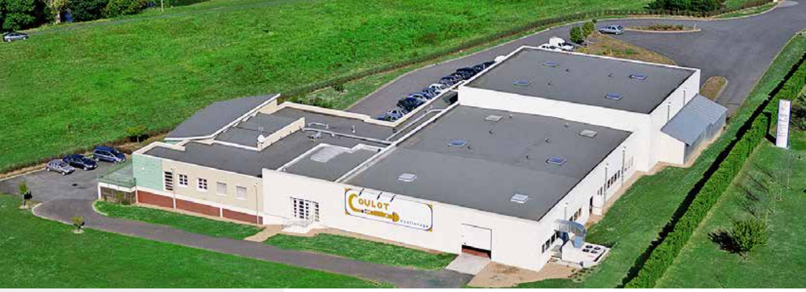
Coulot Découletage tesisinin (Châtellerault - Fransa) havadan görünüşü
